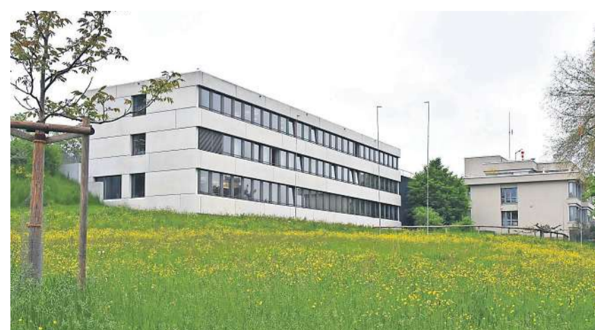
Der Erweiterungsbau des Spitals Wil wird parallel zum Verwaltungstrakt (links) gebaut und wird über das bestehende Spitalgebäude (rechts) erschlossen. z.v.g.
